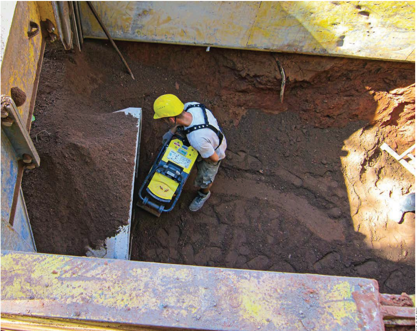
Verdichtungsarbeiten in einem tiefen Graben
